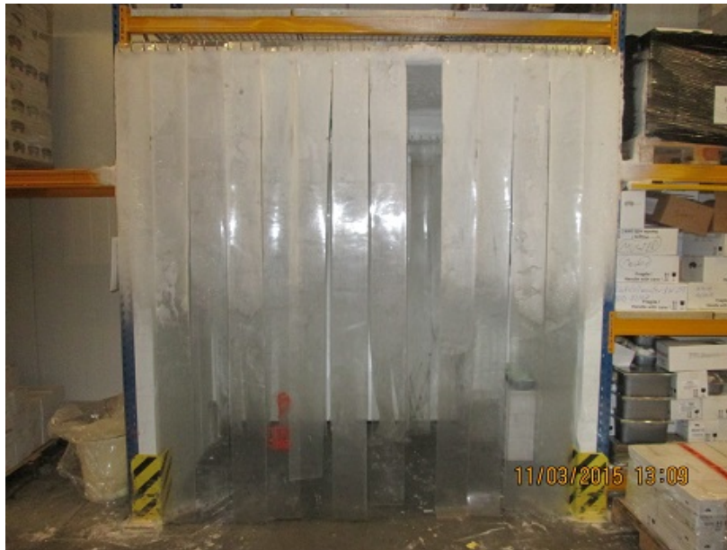
Abbildung 18: Lamellenvorhang im Tiefkühlager
