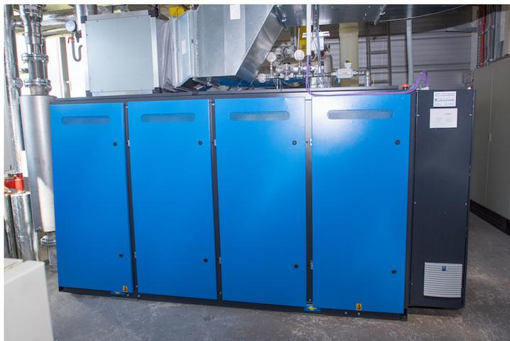
Abbildung 5: BHKW in Modulbauweise
