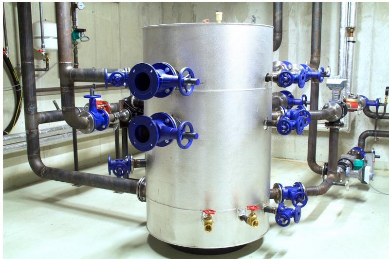
Abbildung 7: Zortström-Verteiler mit möglicher Einschichtung von Wärmeniveaus
