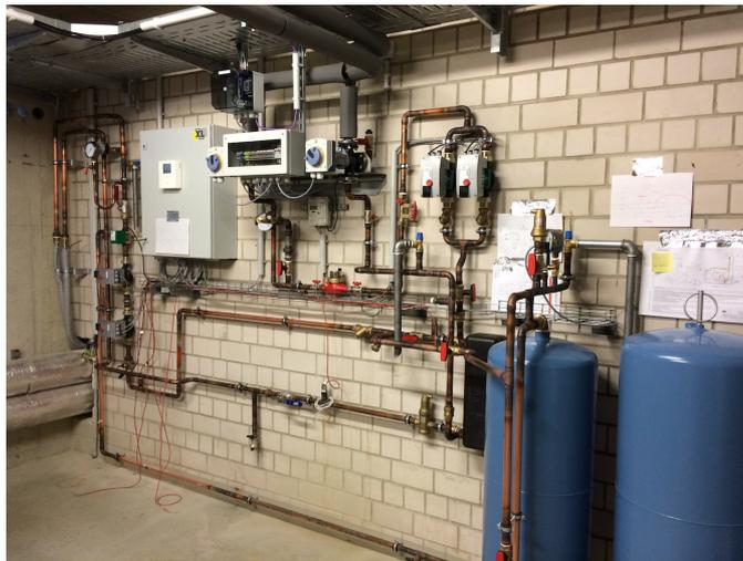
Abbildung 4: Anbindung Solar-Anlage im Keller
