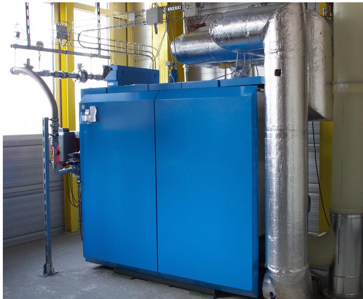
Abbildung 1: Erdgas-Brennwertkessel im Maschinenraum CUTEC
