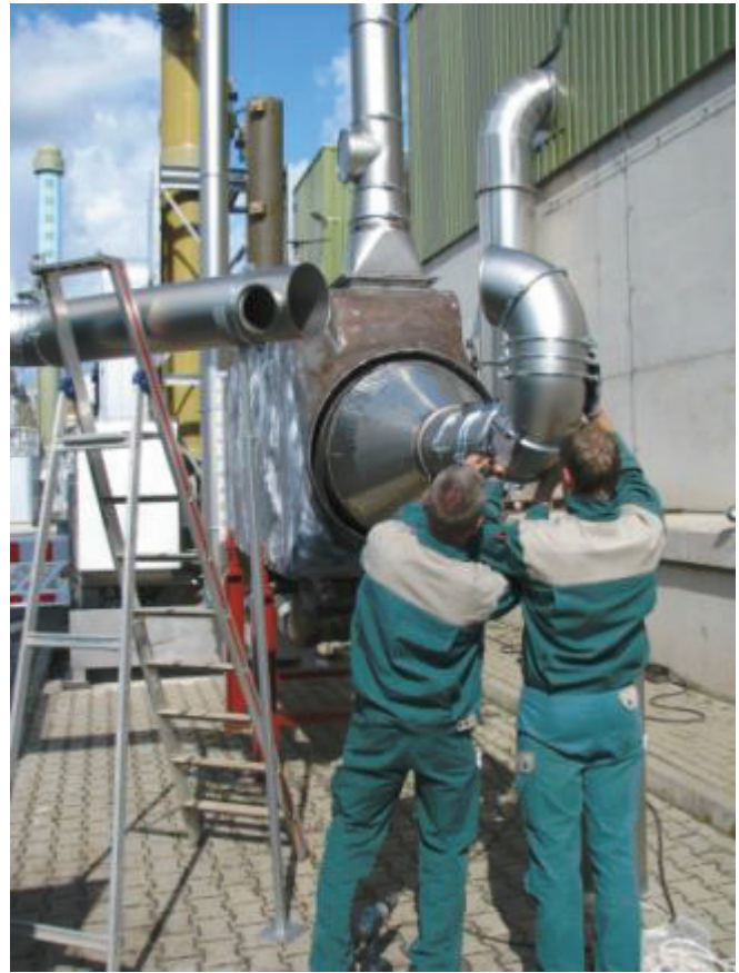
Abb. 6.2-4: Verrohrungsarbeiten an der Anlage
