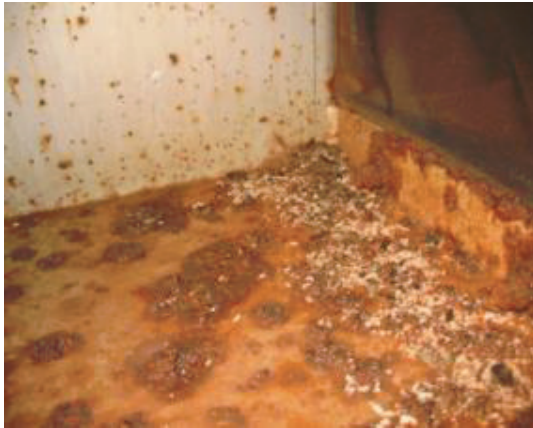
a) Lochfraß im Rohgaskanalbereich
