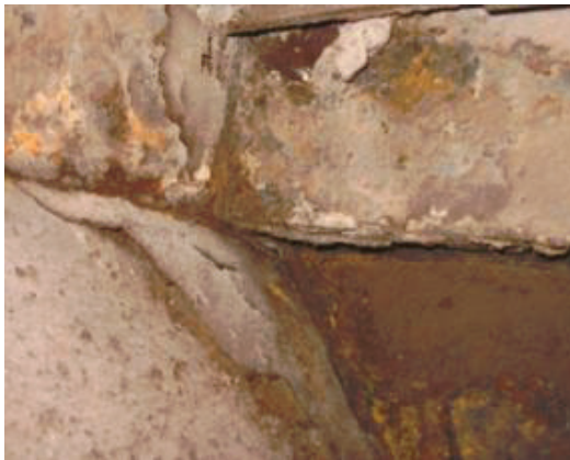
b) Korrosion im Strömungsverteilraum und an einer Spülgasleitung
