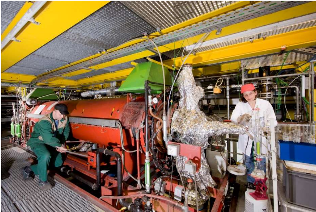
Bild 5: Foto des Technikums-Drehrohres
