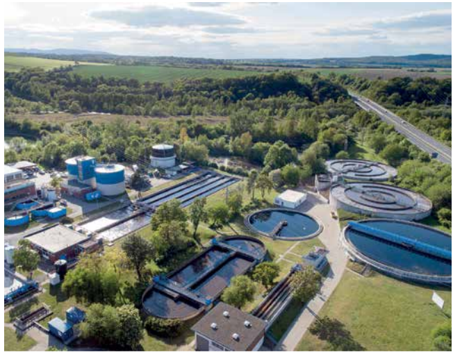
Eurawasser-Kläranlage Goslar, Foto: Copyright U. Mertens
