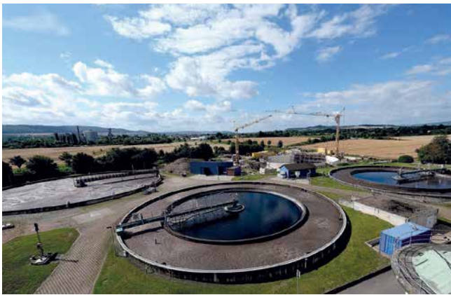
Kläranlage Northeim, Foto: H. Jelinek
