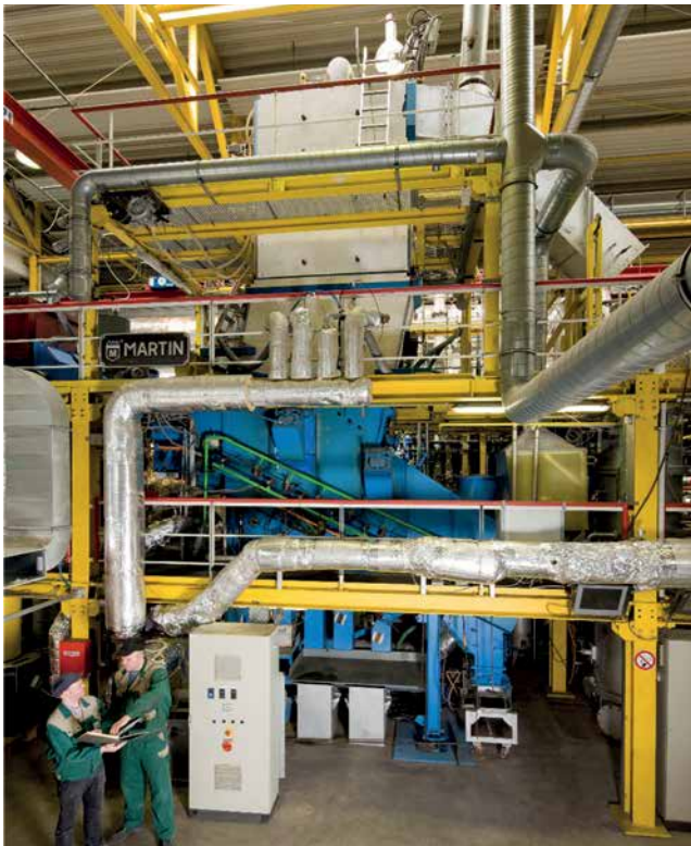
Rückschubrost im CUTEC Forschungszentrum, Foto: CUTEC
